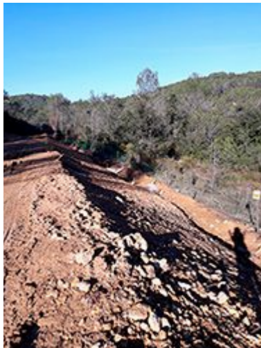
Fossé en pied de talus
