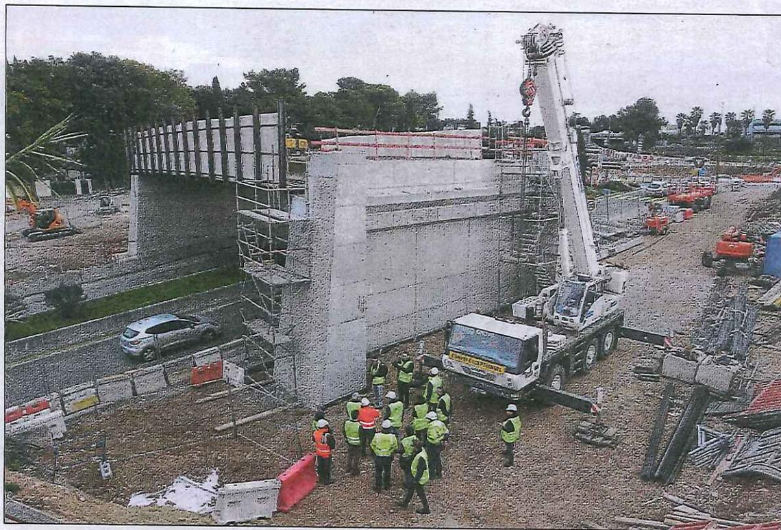
Les murs du pont, qui passe au-dessus de la route des Chappes (RD 535), vont être étayés par des remblais.
